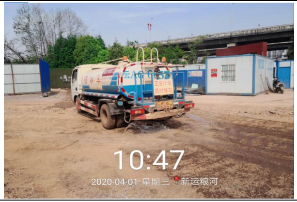
机械洒水抑尘 洒水抑尘
