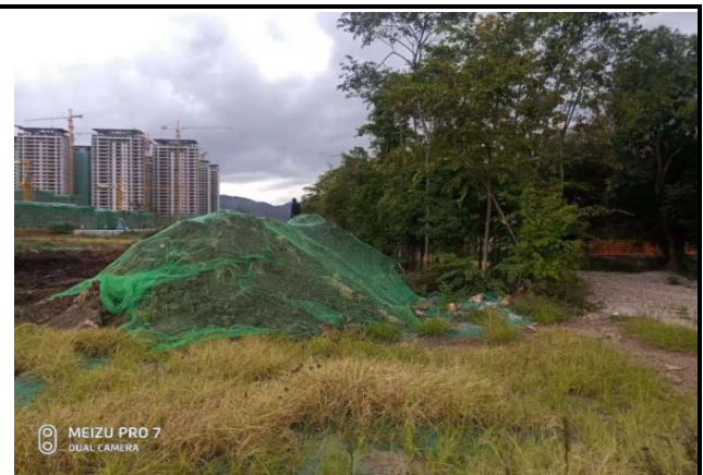
土石方遮盖措施
